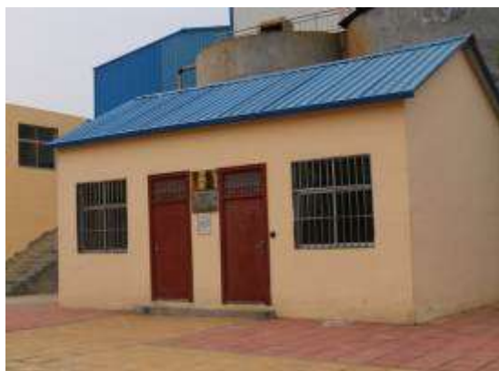
废水在线监测站
