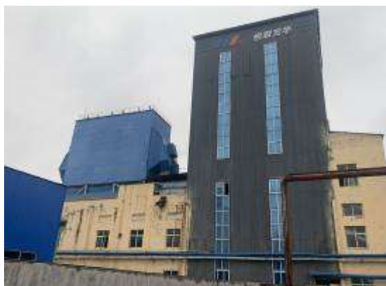
现有碱回收车间（备用）
