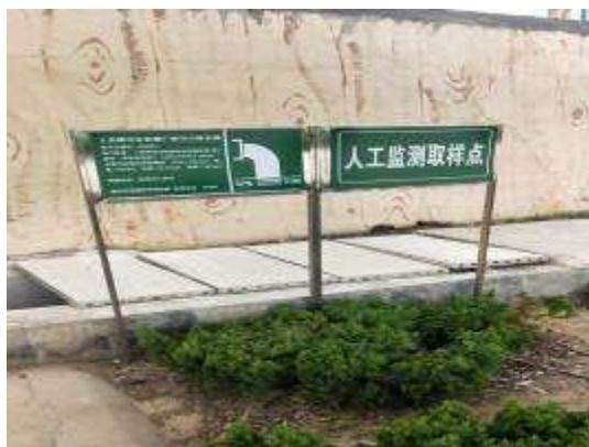
废水排放口标志牌
