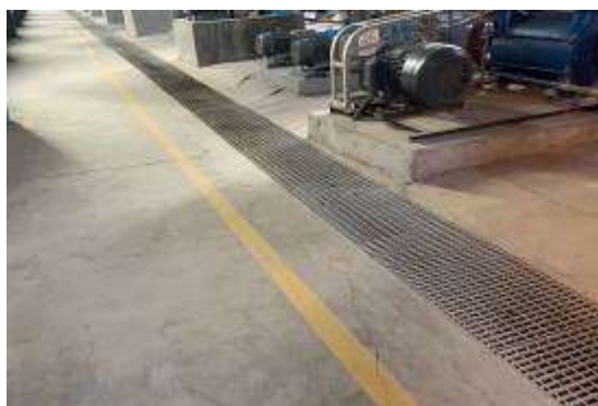
车间内废水收集沟
