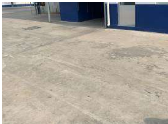
厂区地面硬化
