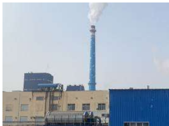
80m 高排气筒
