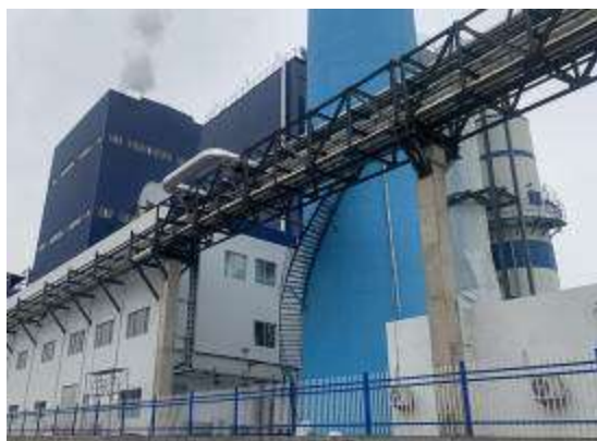
新建碱回收车间
