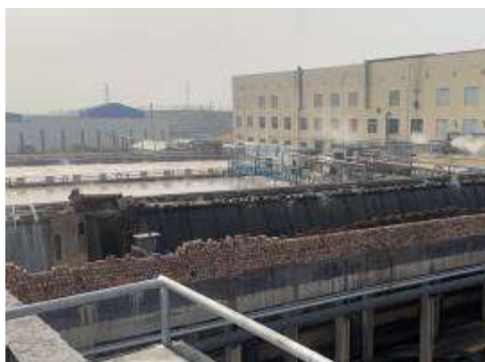
现有污水处理站
