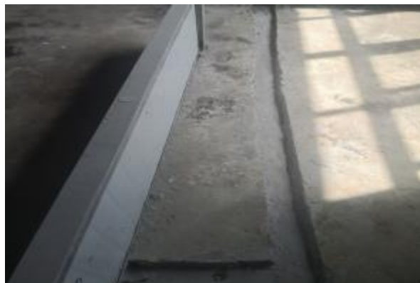
分区围堰及废水收集沟
