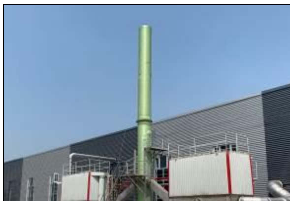
15m 高排气筒
