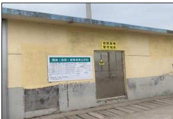
新建危废暂存库
