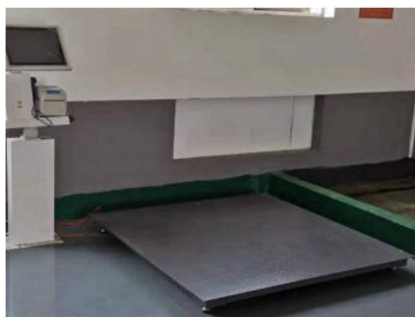
危废库称量设施
