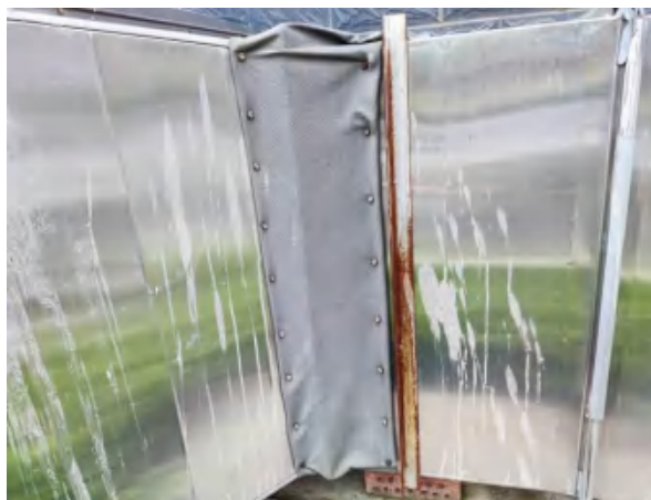
风机软连接减振
