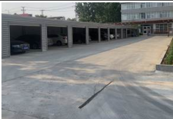
厂区地面硬化
