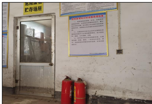
危废库灭火器
