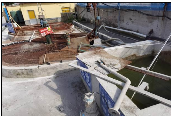
砂石分离机沉淀池
