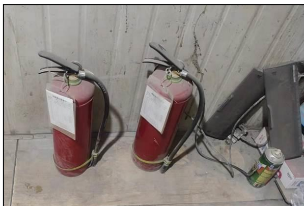
控制室灭火器
