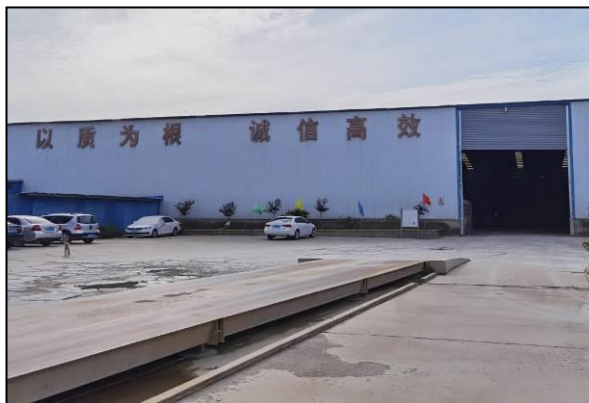
厂区内地面硬化
