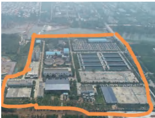
万吨污水处理站
