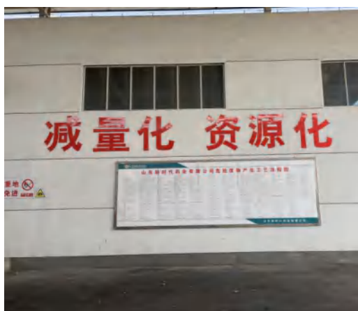
危险废物贮存场所
