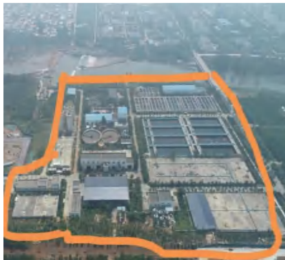
图 9-5 万吨污水处理站
