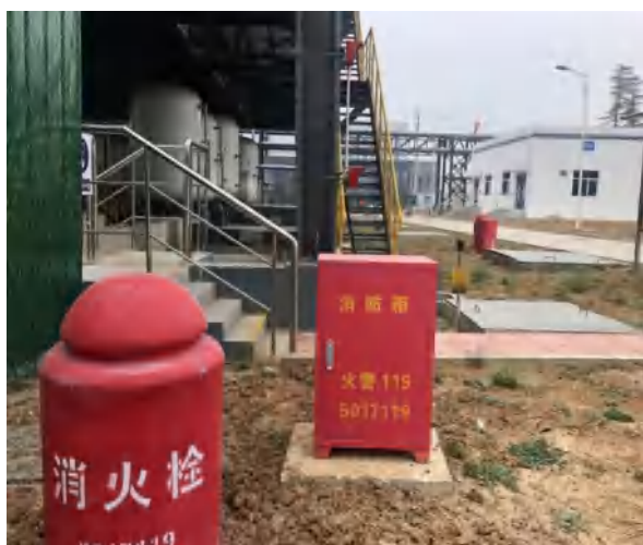
图 9-9 消火栓消防设施图
