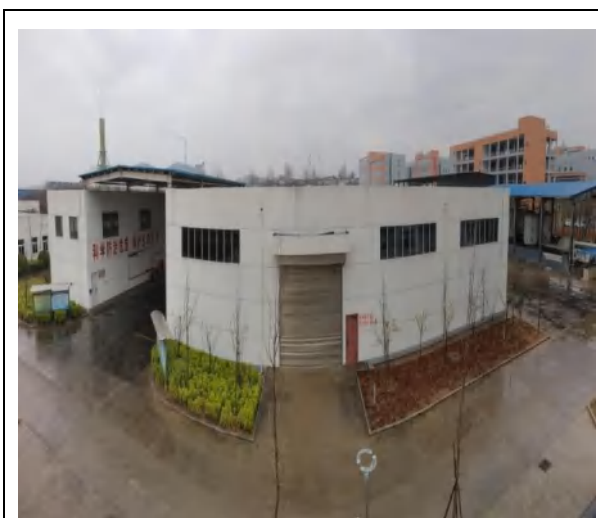
图 9-6 危险废物暂存区域
