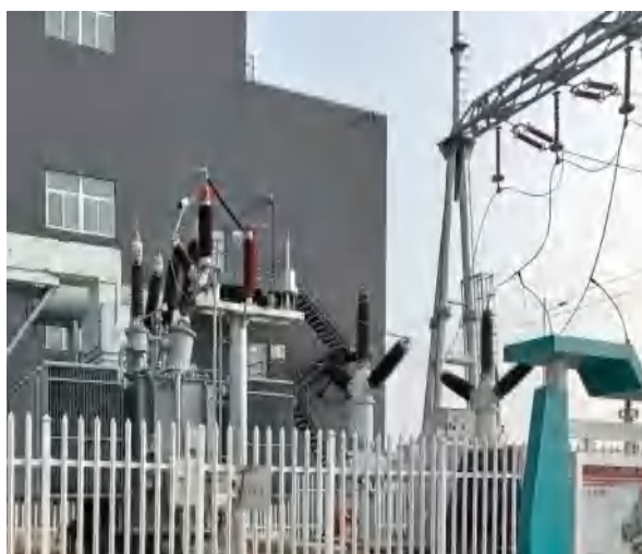
项目现场情况图
