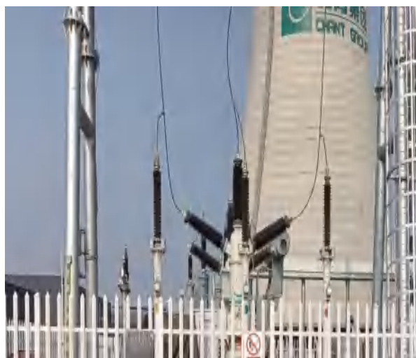
项目现场情况图
