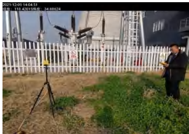
2#站址南侧围墙外距围墙 5 米处 辐射现场检测图
