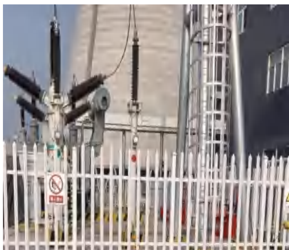
项目现场情况图
