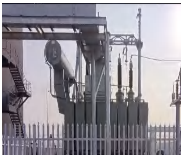
项目现场情况图
