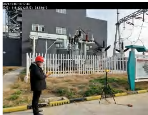
3#站址西侧围墙外距围墙 5 米处 辐射现场检测图
